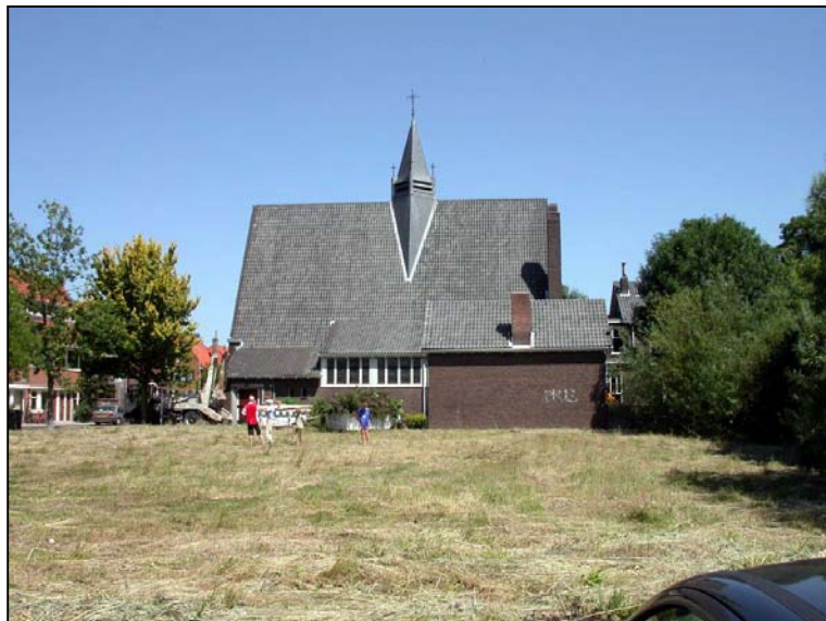
Amsterdamse School architectuur aan de Schoolstraat
