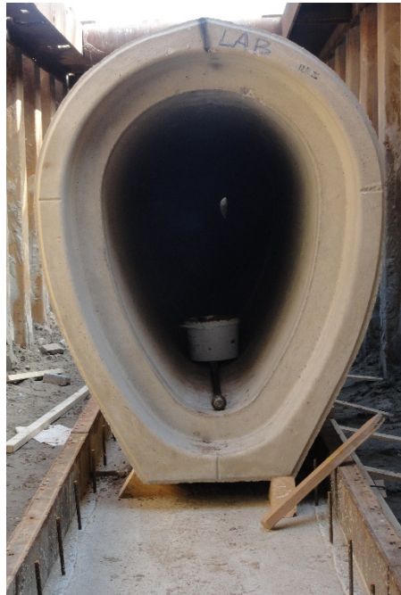
Betonnen rioolbuis op betonnen funderingsbalk
