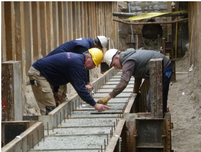
Betonnen funderingsbalk Schoolstraat
