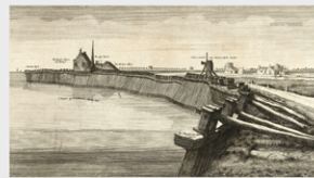
Afbeelding van de dijk zoals deze vroeger is aangelegd met behulp van houten palen. Vanaf 1730 zijn de palen vervangen door stenen vanwege paalworm.
